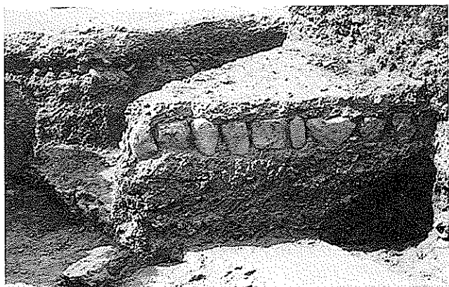
Fig. 4: Cimentación de la calzada Archivo MNAR
