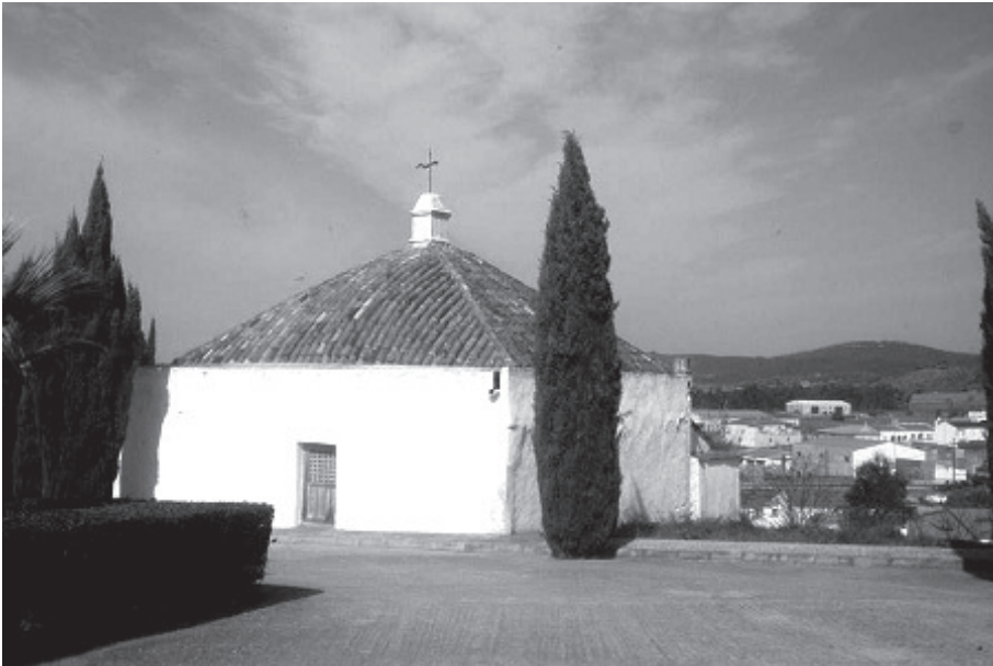
Fig. 4.- Casa de nieve de Villar del Rey
