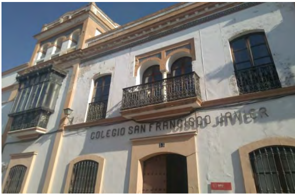
Fig. 4: Fachada con torreón-mirador en un lateral.
