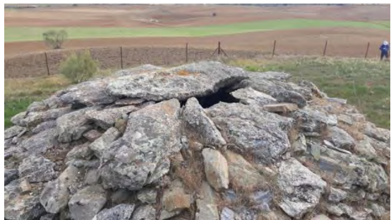
Fig. 5: Cierre de la bóveda.
