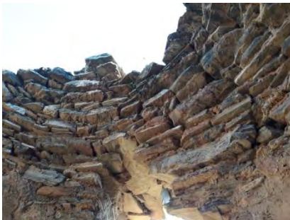
Fig. 4: Hiladas de la bóveda.
